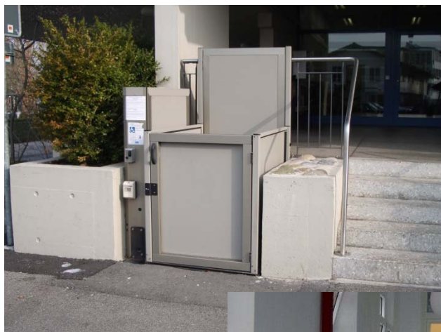
Accès à l'entrée
