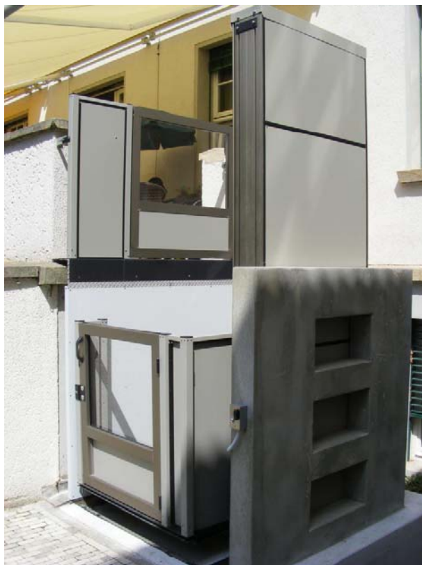
Accès au balcon
